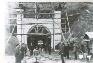
第1疏水第2トンネル東口で洞門工事(明治21年)
